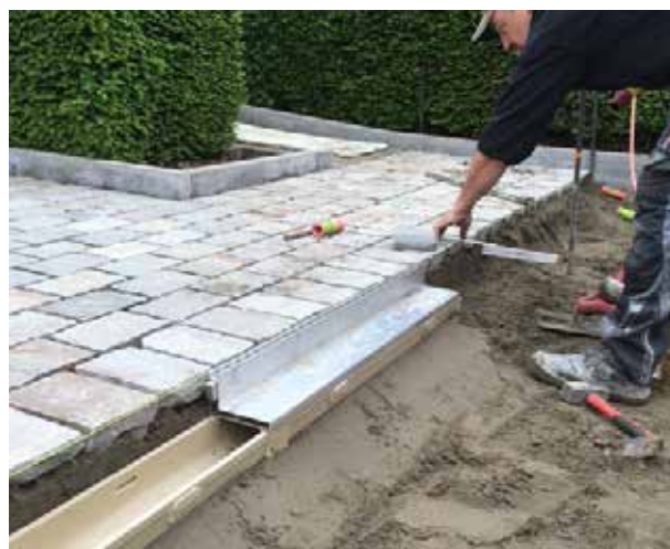
Caniveau en polymère + grille passerelle en galva
